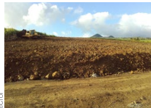
Utilisation de déblais végétaux de chantiers en amélioration foncière agricole.
